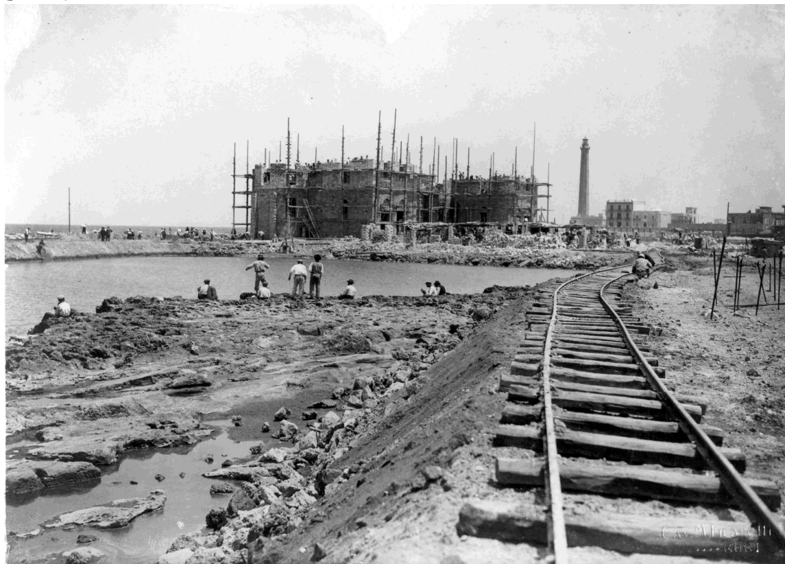
Si lavora alla colmata del pantano dove sta sorgendo la Fiera del Levante. Sullo sfondo l'ingresso monumentale è a buon punto.
